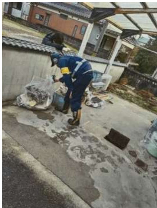
漏水調査 (音聴棒)
