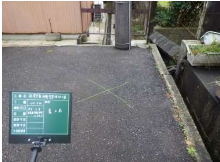
漏水箇所特定
