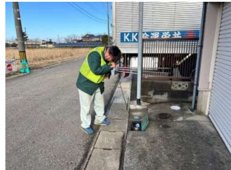
漏水調査（音聴棒）
