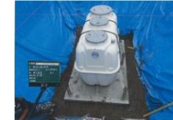
合併処理浄化槽
