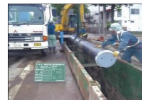
配水管の耐震化
