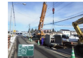
雨水管の整備
