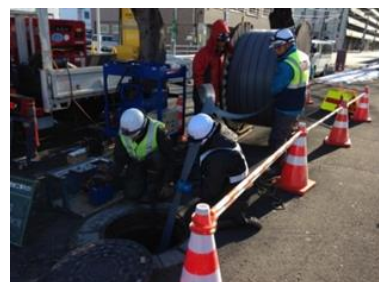
下水道管渠の長寿命化
