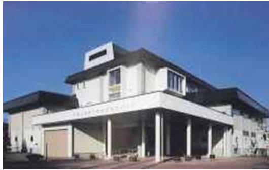
十勝川流域下水道浄化センター
