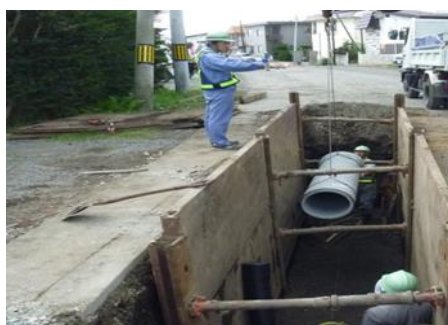
雨水管の整備
