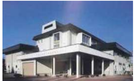
十勝川流域下水道浄化センター
