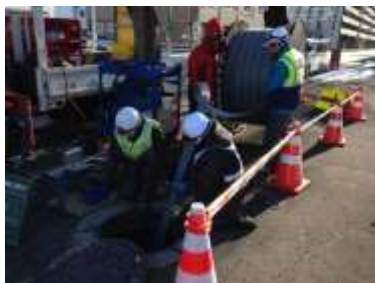
下水道管渠の長寿命化
