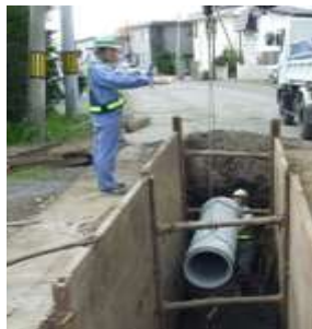
雨水管の整備
