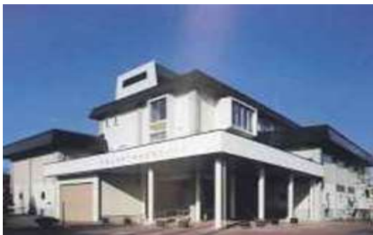
十勝川流域下水道浄化センター
