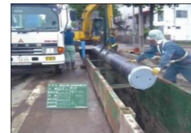
配水管の耐震化
