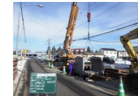
雨水管の整備
