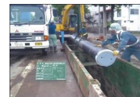
配水管の整備
