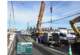
雨水管の整備
