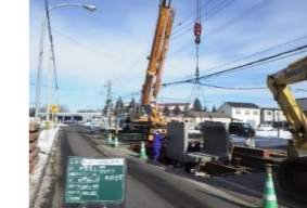
雨水管の整備
