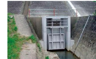
河川水侵入防止ゲートの整備
