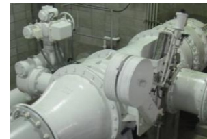
緊急遮断弁の設置
