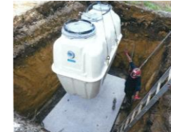
合併処理浄化槽
