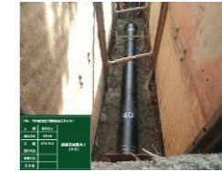
汚水処理統合 圧送管の整備
