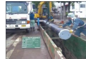
配水管の整備
