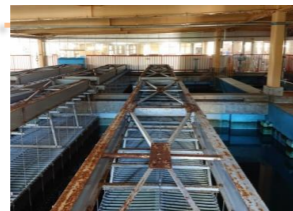
稲田浄水場 沈殿池設備 (傾斜板 架台)
