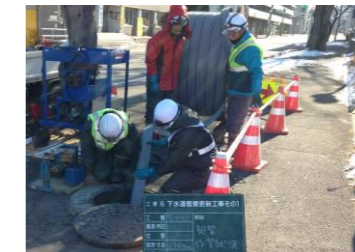
下水道管渠の長寿命化
