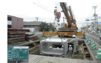
雨水管の整備
