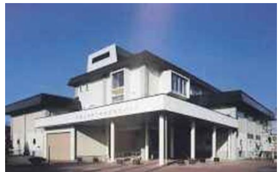
十勝川流域下水道浄化センター
