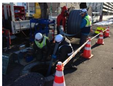
下水道管渠の長寿命化
