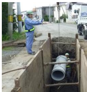
雨水管の整備
