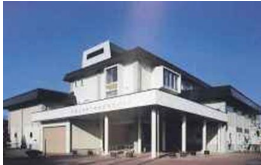
十勝川流域下水道浄化センター
