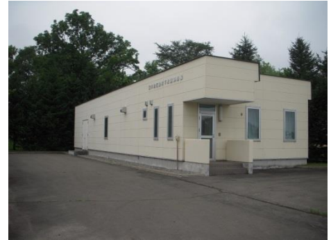
清川下水処理場
